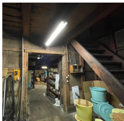
図 9 仕込蔵出入口付近 (著者撮影(2022))
